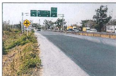
กม.17+000 จุดตัดกับถนนสาย พบ.1010
