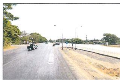
กม.2+100 จุดตัดกับถนนเลียบคลองชลประทาน
