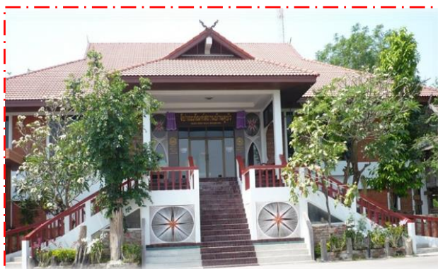
ภาพที่ 4.4 อาคารจิปาละภัณฑ์สถานบ้านคูบัว
